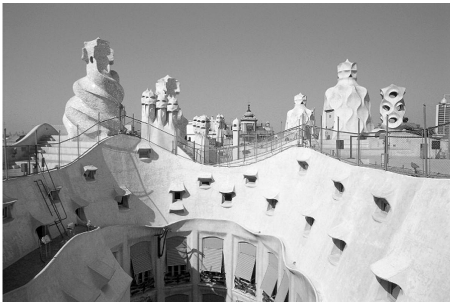
A. Gaudi - Toit de la Casa Milà
