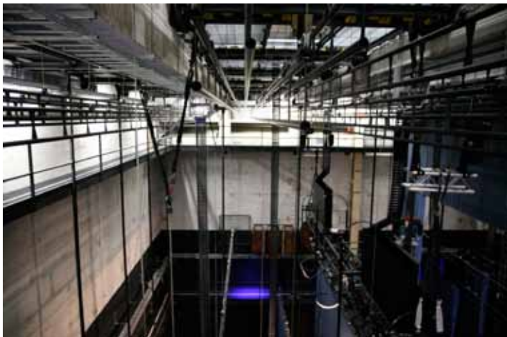
Blick in den Schnürboden des Bühnenraumes.
